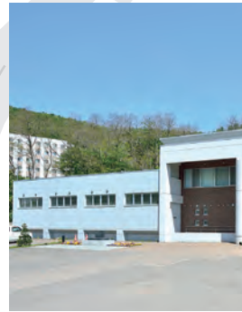
⑪ 第1体育館 【平成18年3月】 1st Gymnasium
