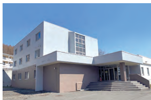
⑩ サークル共用施設【昭和59年3月】 Student Activity Bldg
