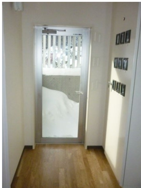
Bユニット側 非常口(1~5階)
