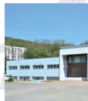
⑪ 第1体育館 【平成18年3月】 1st Gymnasium
