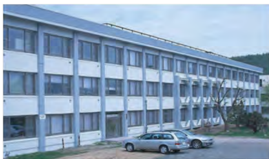
① 1号館(研究棟) 【昭和41年3月, 平成5年5月増】 Professors' Research Bldg
