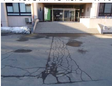
道路（アスファルト）
