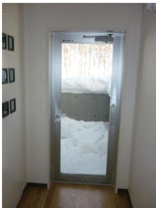
Aユニット側 非常口（1～5階）
