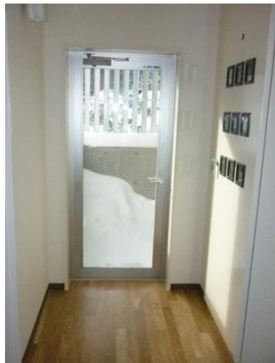
Bユニット側 非常口（1～5階）
