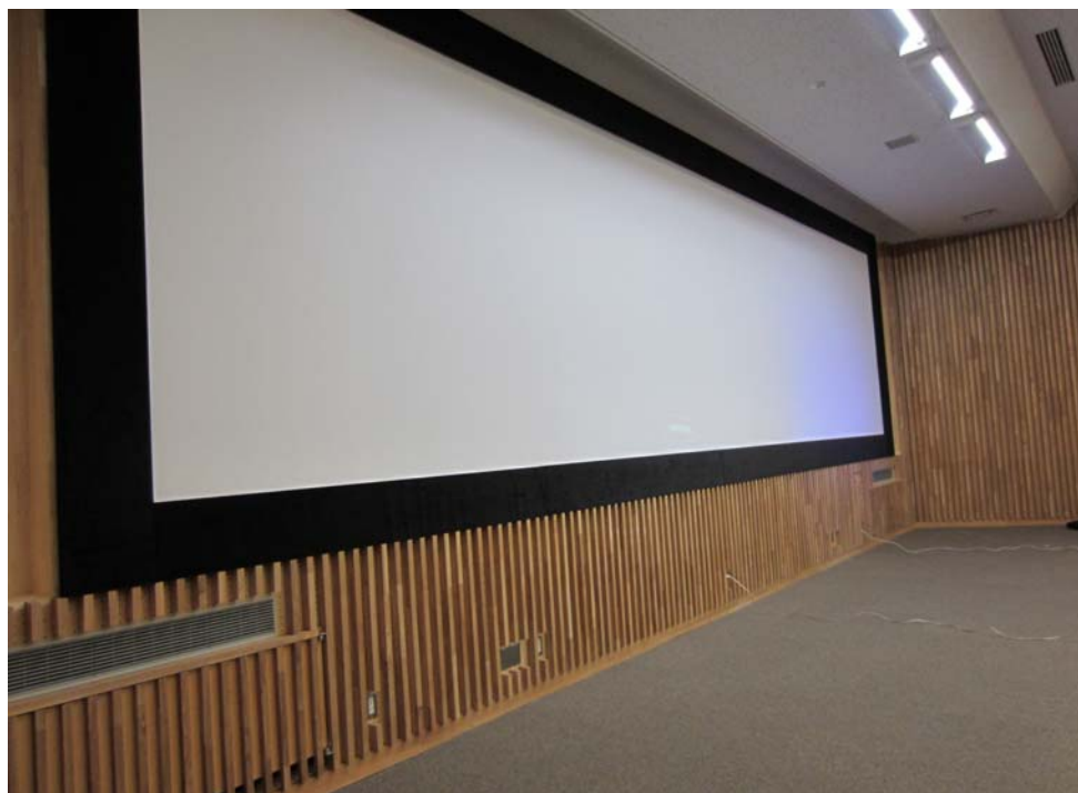
教壇を撤去して、段差を解消した
