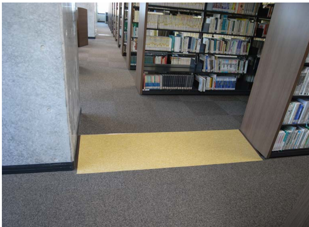
段差部分に色違いのスロープを設置した
