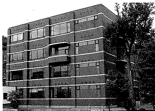
平成6年3月30日 第3講義棟新設
