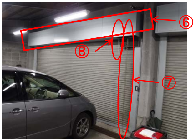
図6 車庫シャッター
