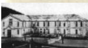
第1寮(北斗寮) 大正2年(1913年)建設 昭和35年(1960年)廃寮 収容人数 51人 室数 25
