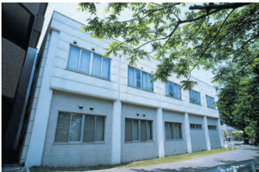
⑦ 情報総合センター【昭和63年3月】 Information and Communications Technology Center
