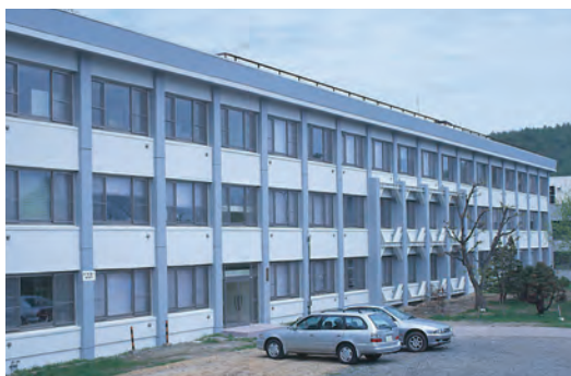
① 1号館(研究棟) 【昭和41年3月,平成5年5月増】 Professors' Research Bldg
