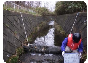
水路部に枕ジャカゴを合計20本設置しました
