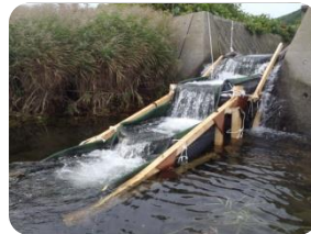
河口の段差に階段魚道が完成しました
